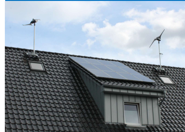
Entkoppelte Aufdachmontage auf Solarschiene (vgl. S. 24)
