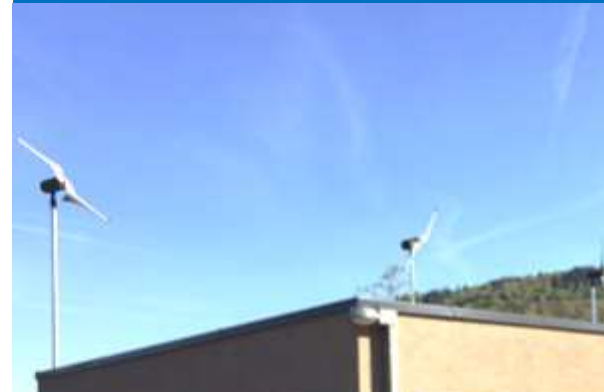
Flanschmontage am Flachdach
