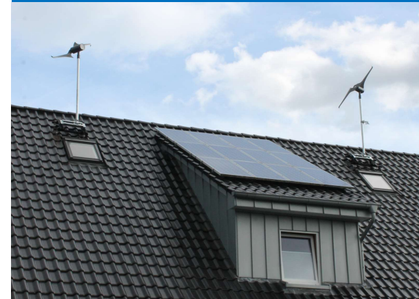
Entkoppelte Aufdachmontage auf Solarschiene (vgl. S. 24)
